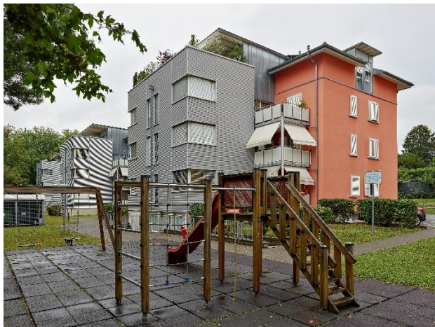
Immeuble Corbettes 1, 3, 5, 7, 9 - Photo : © Michel Bonvin
